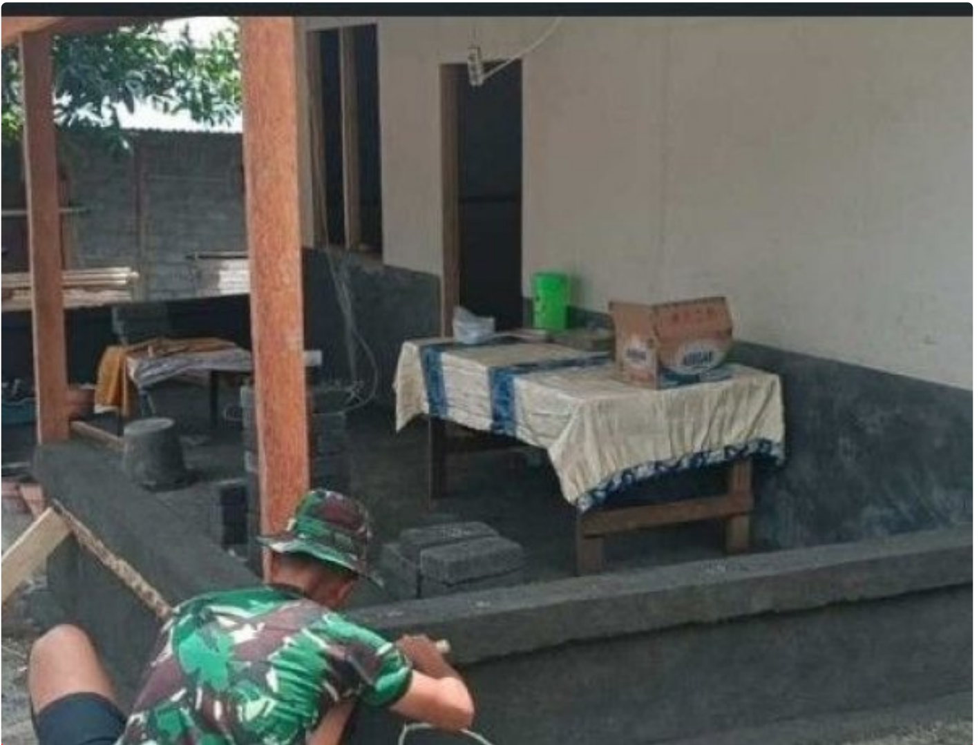
Satgas TMMD Kodim 1310 Bitung dalam Pekerjaan RTLH
