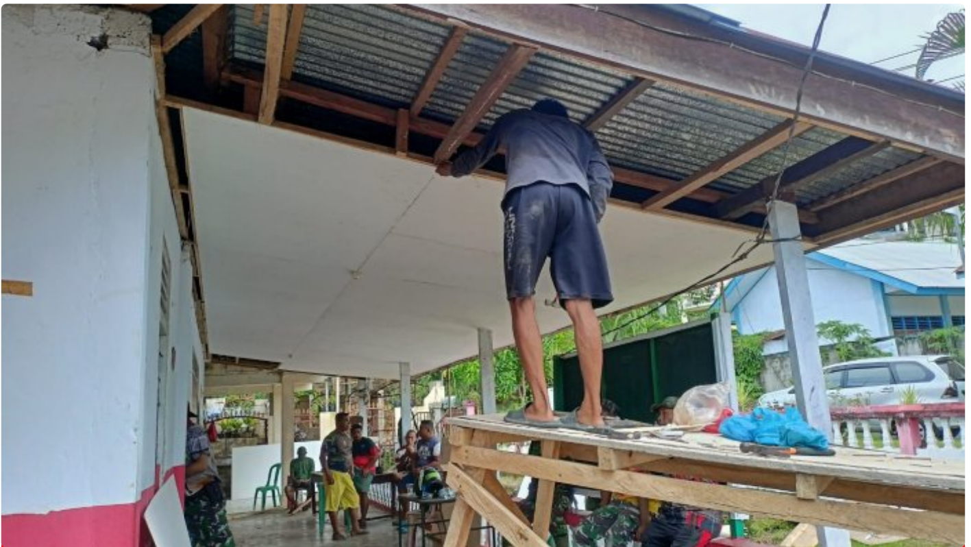
Satgas TMMD Renovasi Kantor Kelurahan Tandurusa
