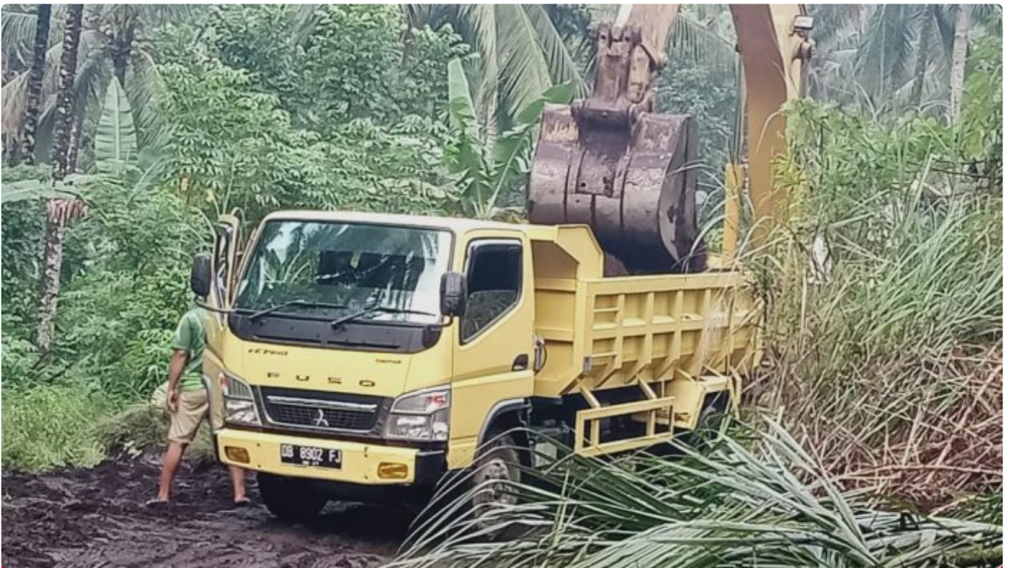
Dump Truk angkut Material Tanah Timbunan Pembangunan Sarana Jogging Track pada TMMD Ke 116 di Kelurahan Tandurusa
