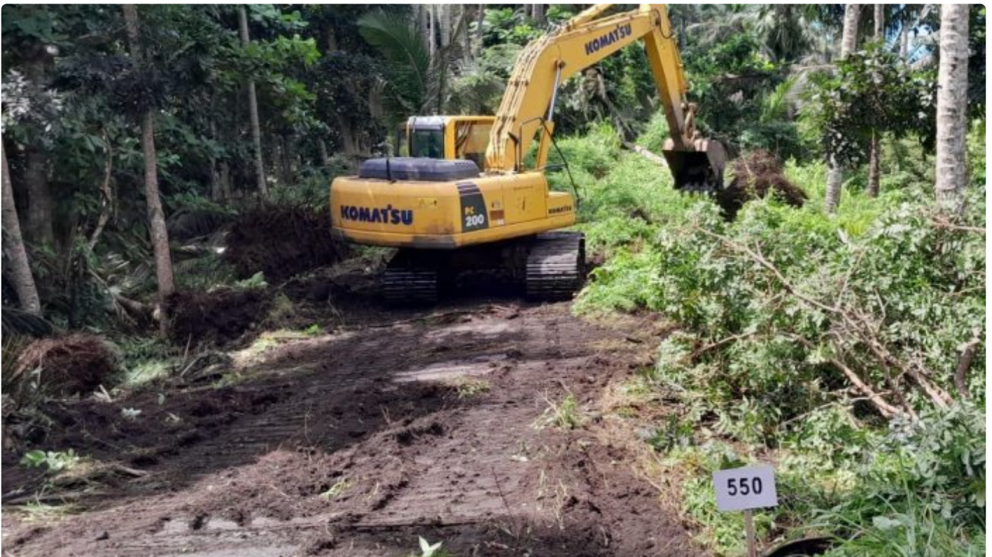
TMMD Ke-116, Pembukaan akses jalan industri Tani di Kelurahan Tandurusa
