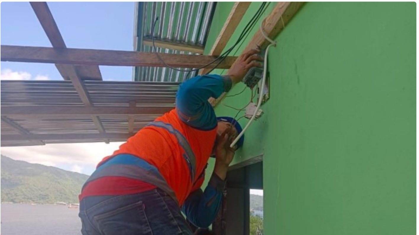
Pemasangan Instalasi RTLH oleh Satgas TMMD Ke-116 Kodim 1310 Bitung
