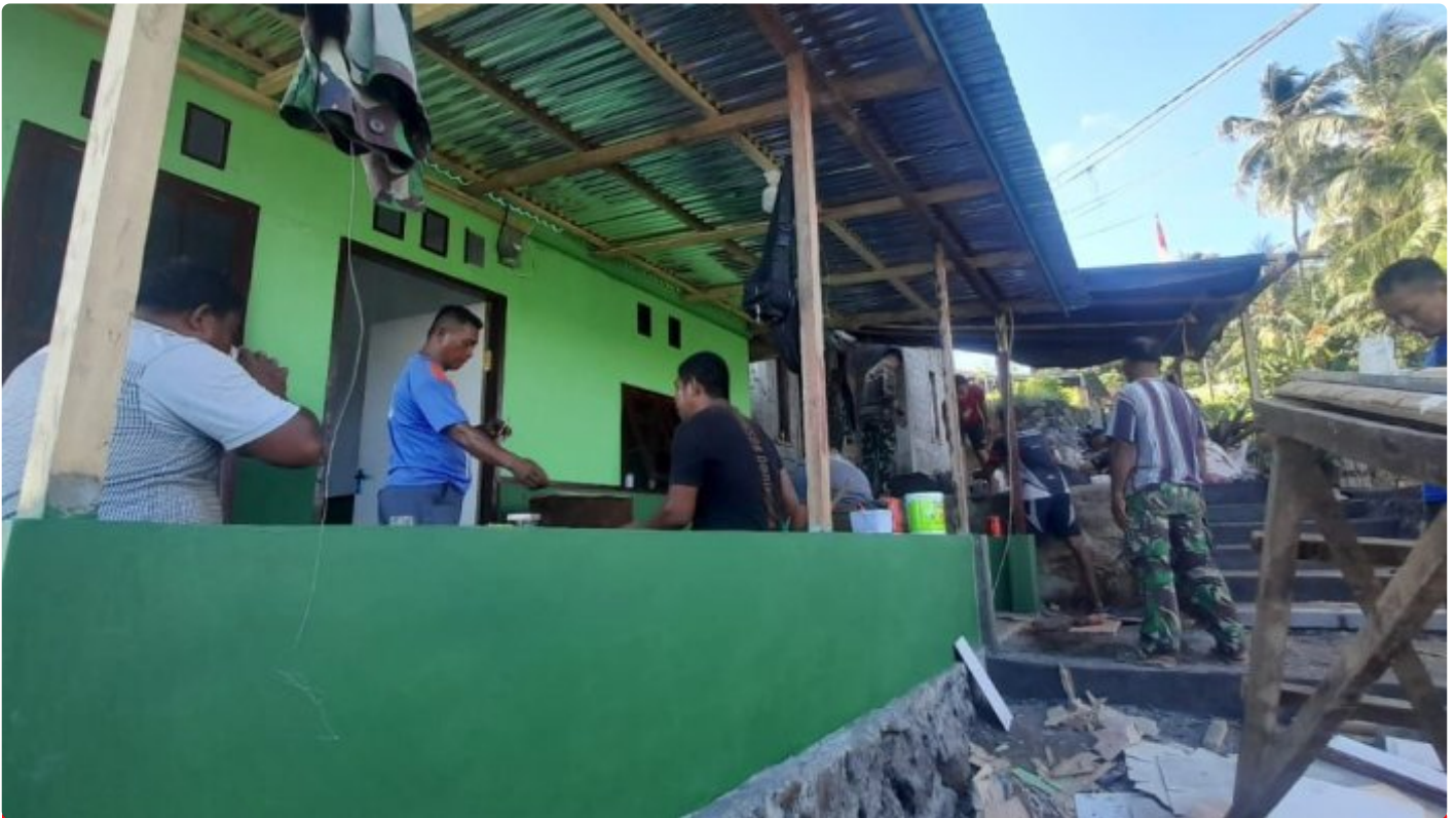
Pembangunan RTLH Keluarga Galvin Karaki pada TMMMD Ke-116 Kodim 1310 Bitung
