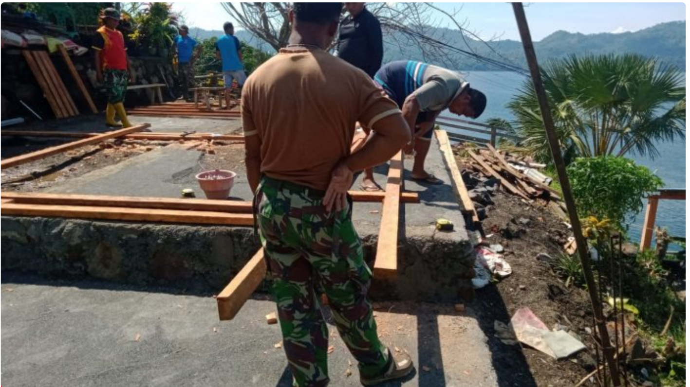
Satgas TMMD Ke 16, pada Pekerjaan RTLH Warga Kelurahan Tandurusa
