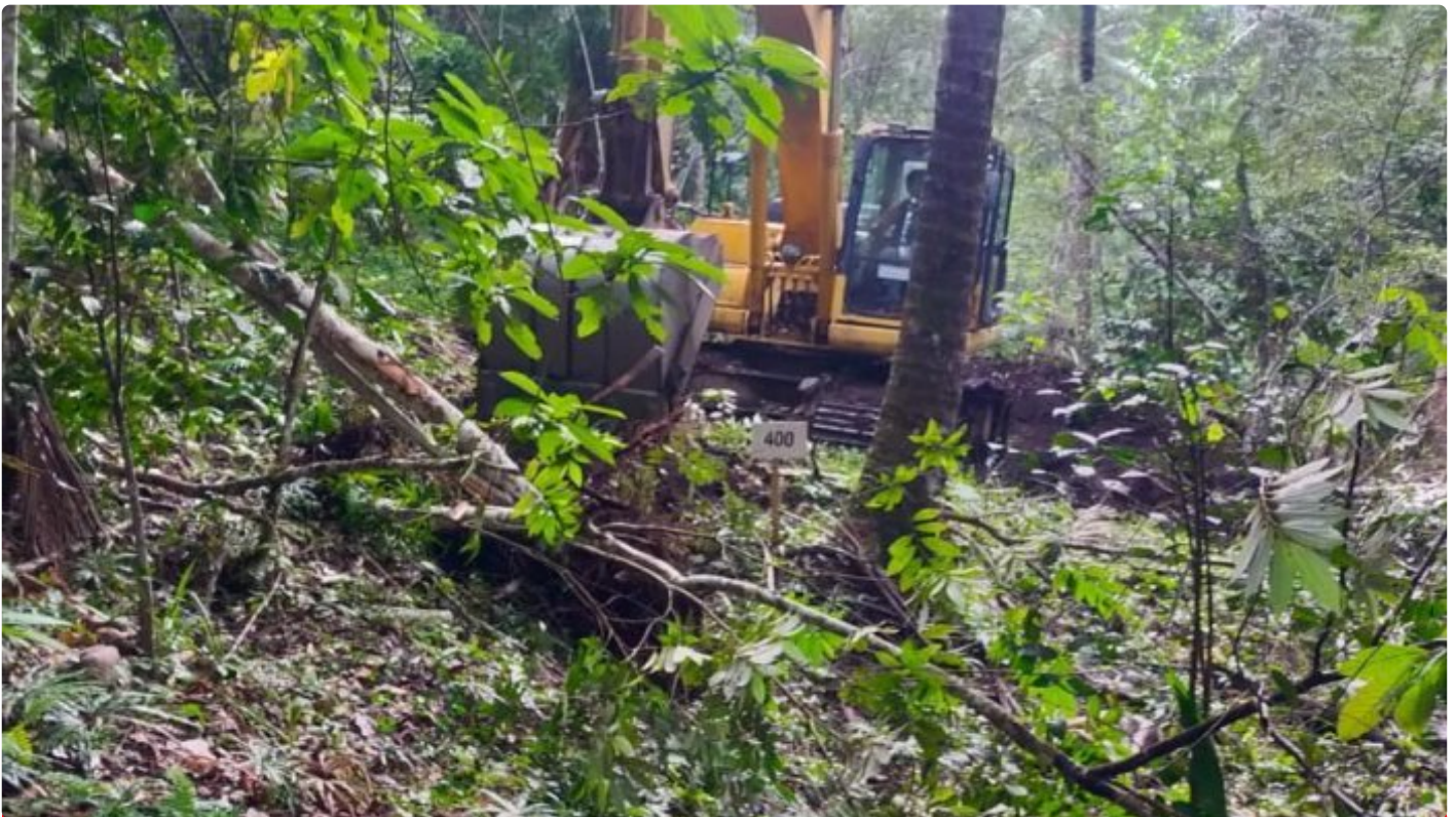
Pekerjaan akses Jalan TMMD Ke-116
