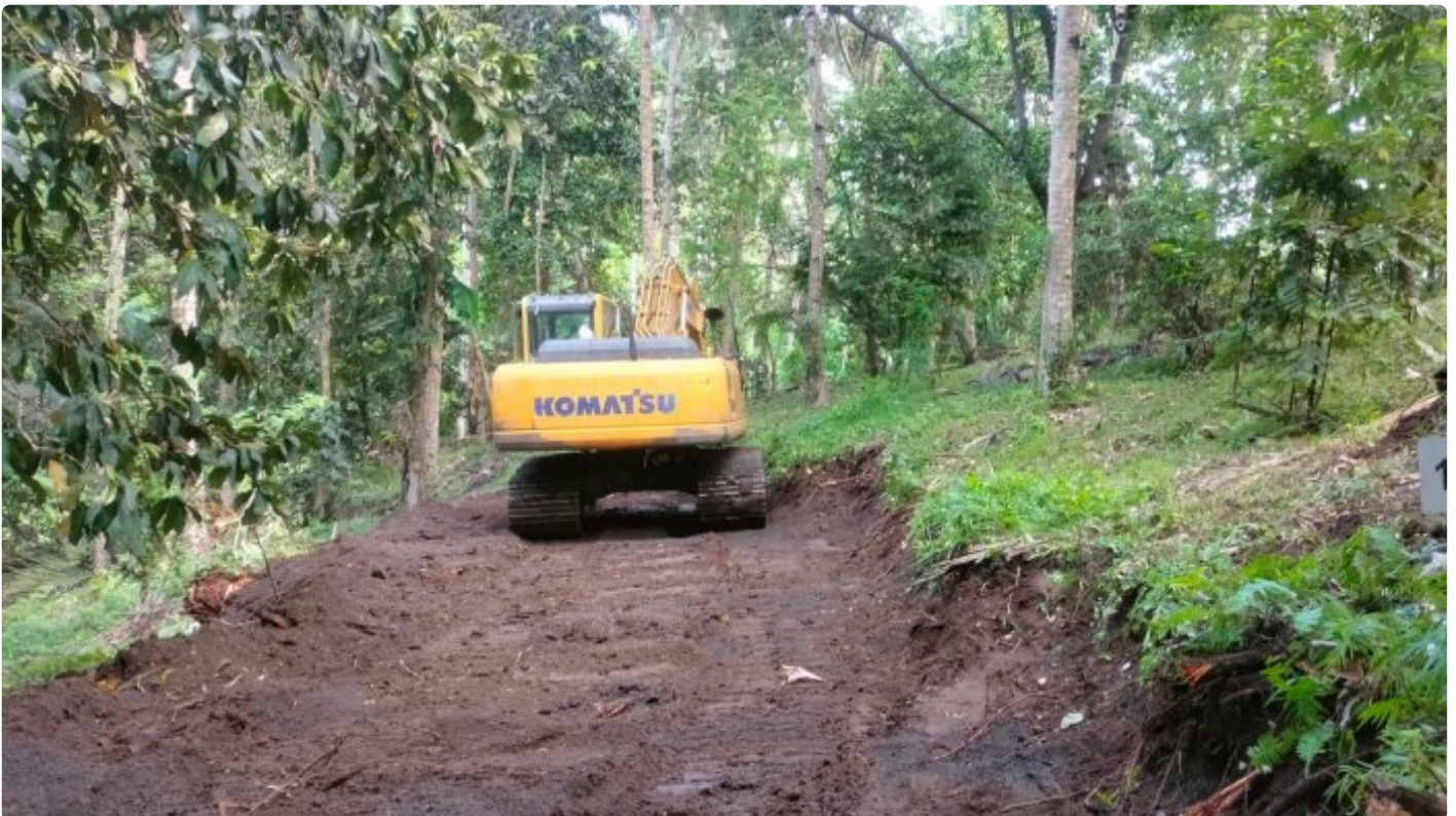
Pekerjaan Perintisan Jalan Pertanian pada TMMD Ke-116 Kodim 1310 Bitung di Tandurusa
