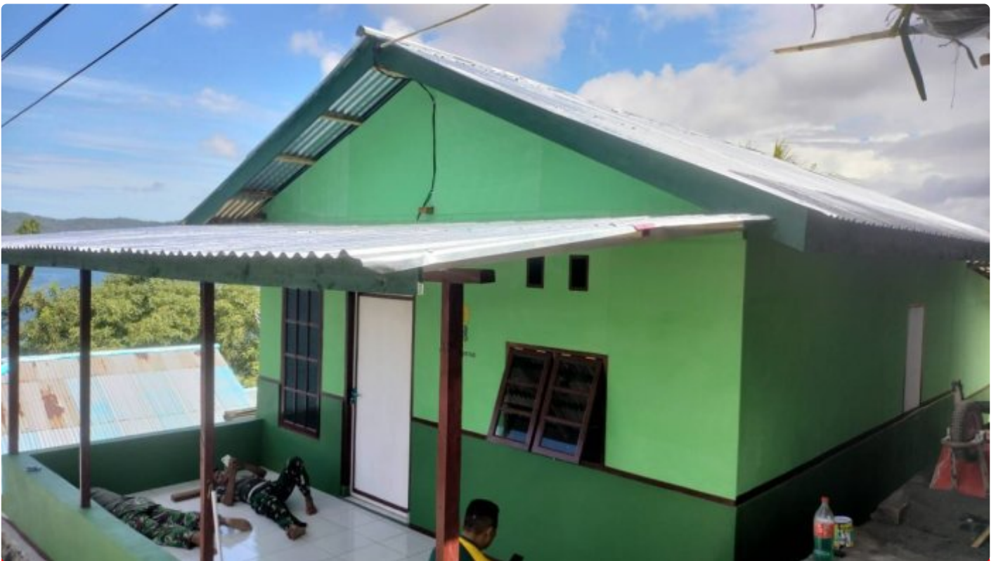
Renovasi RTLH TMMMD Ke-116 Kodim 1310 Bitung
